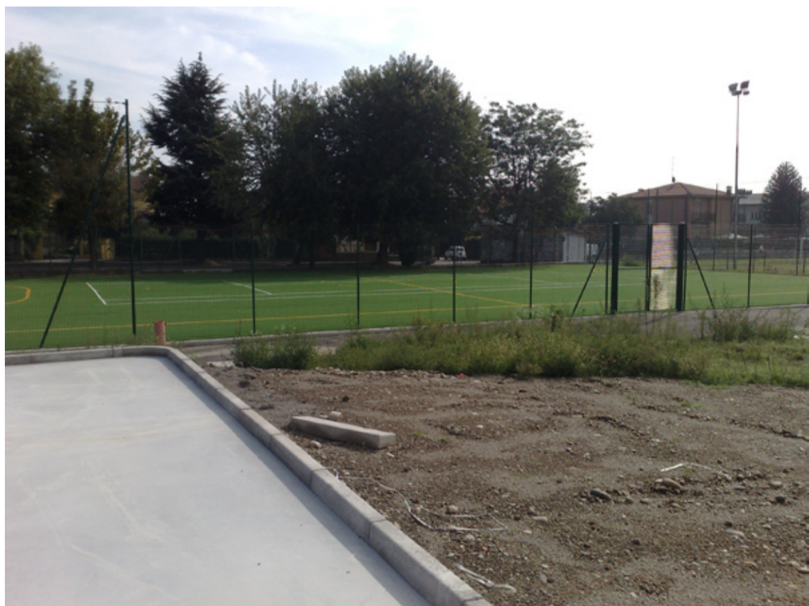
Nelle foto il dettaglio dei lavori effettuati al Centro Sportivo Comunale di via Leonardo Da Vinci, dove sono stati realizzati campi per la pratica del calcio, del tennis, del beach volley, della pallavolo e della pallacanestro
